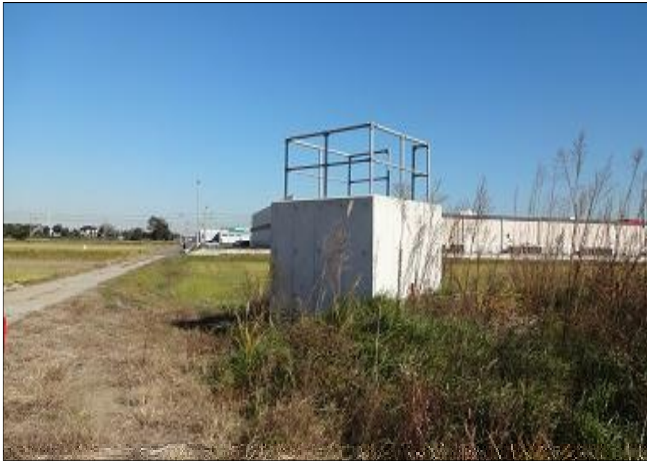
一宮川注水工吐水槽
