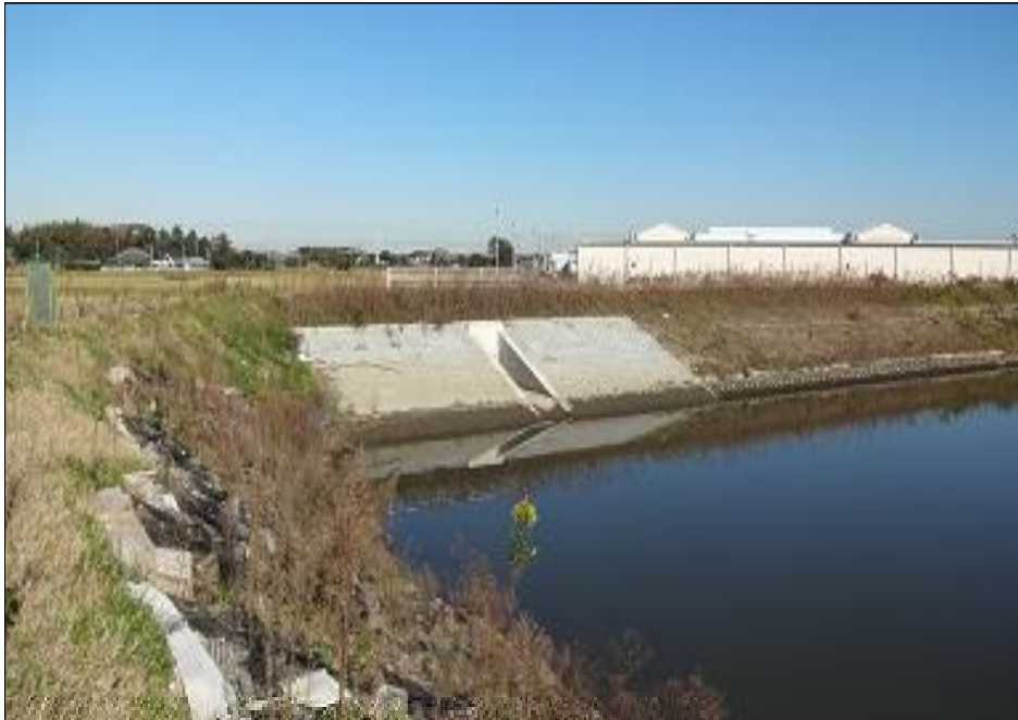
一宮川注水工注水口
