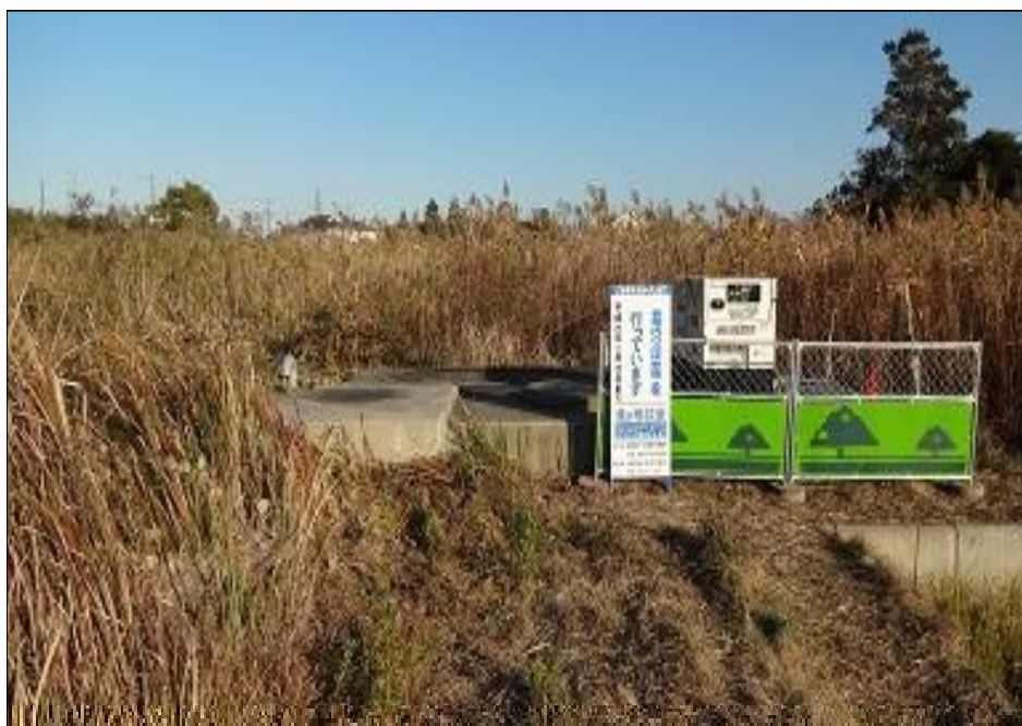
12号排泥工 (8-1号制水弁工併設)
