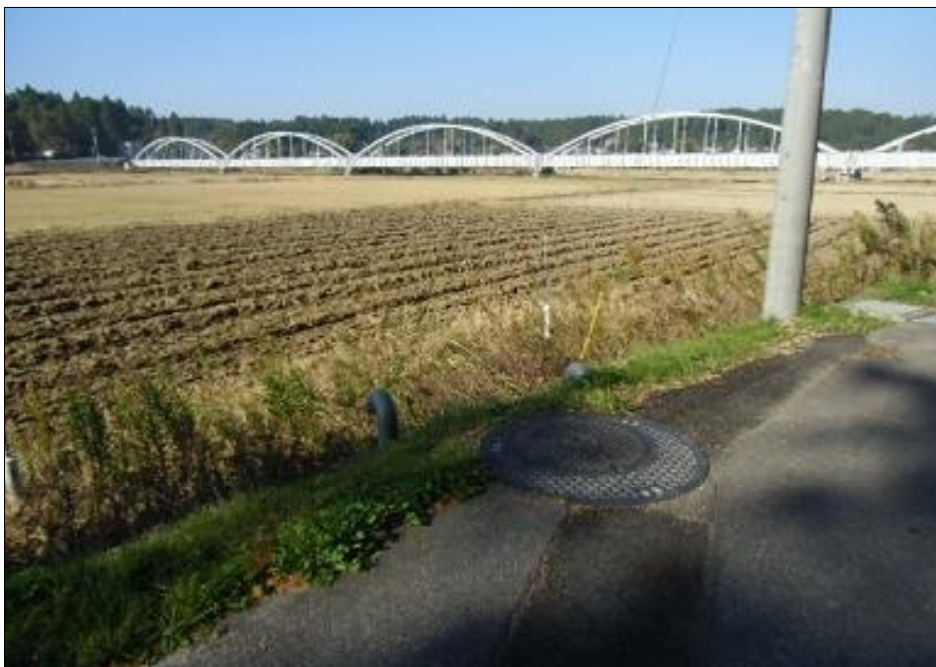
1号流量計室工
