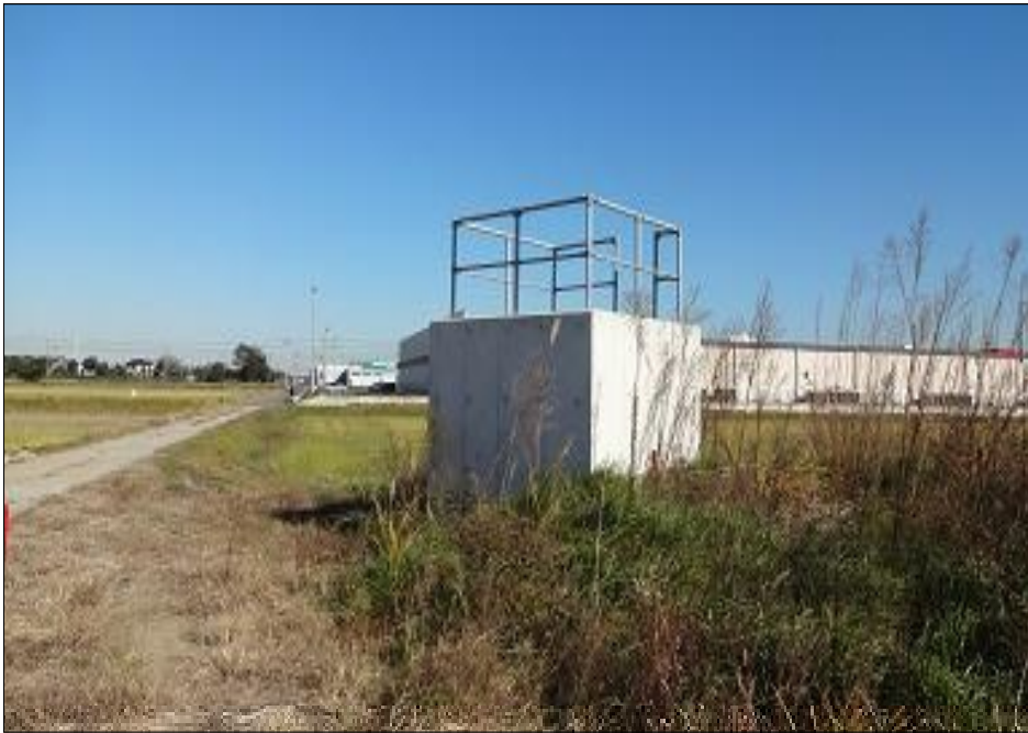
一宮川注水工吐水槽
