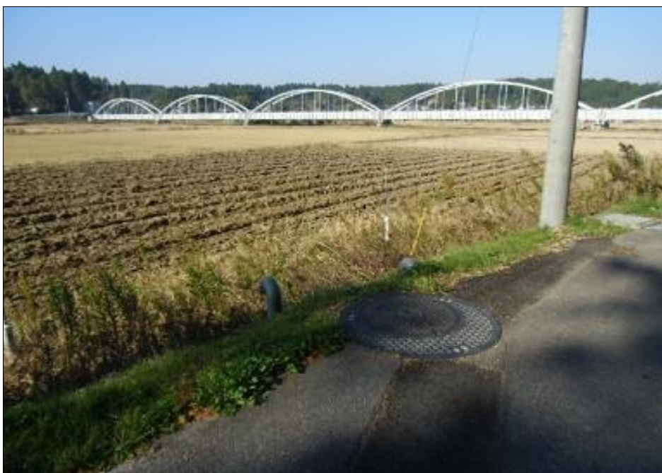
1号流量計室工
