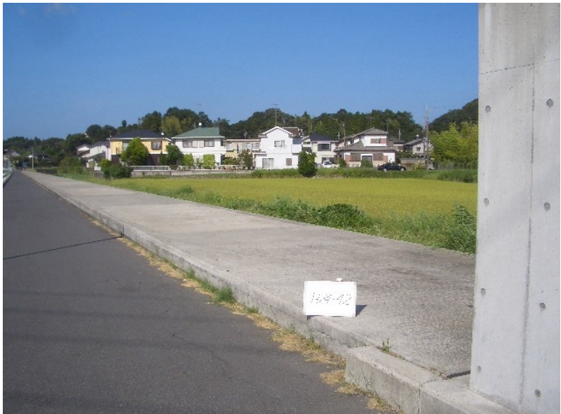
H24-42 金谷郷地区復旧工事
