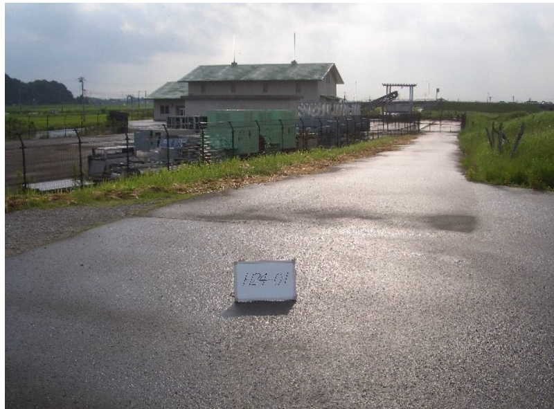
H24-01 第1揚水機場 特別高圧受変電 設備建設工事
