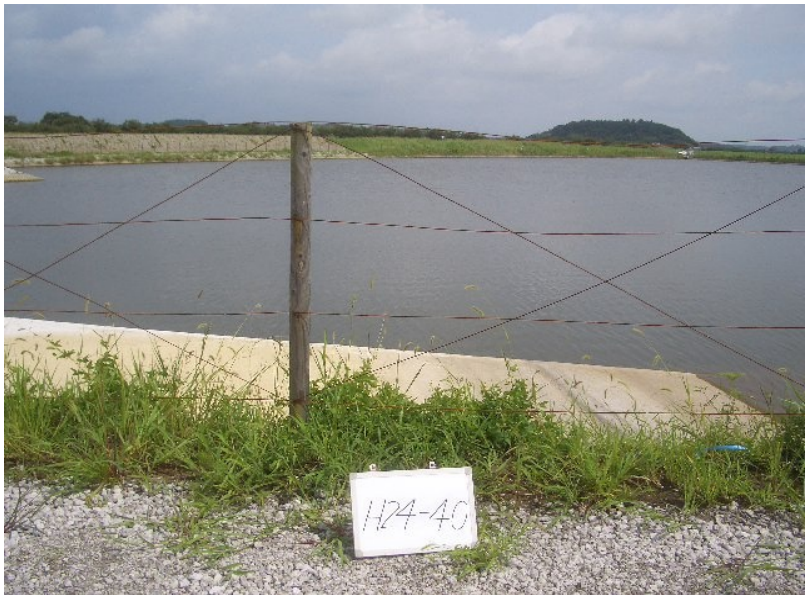
H24-40 栗山川第1調整池 周辺整備工事
