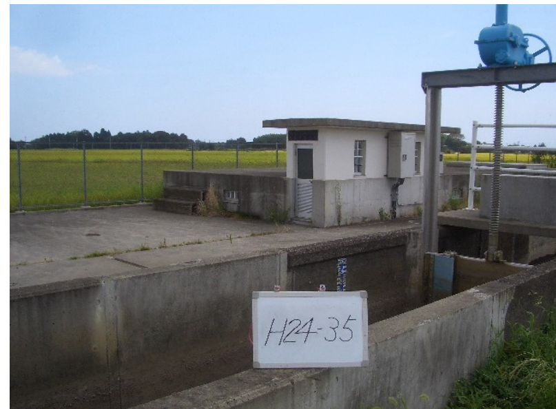
H24-35 東金東分水工 場内整備その1工事
