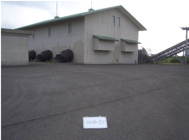
H24-37 第1排水機場 情報伝送ケーブル 補修工事
