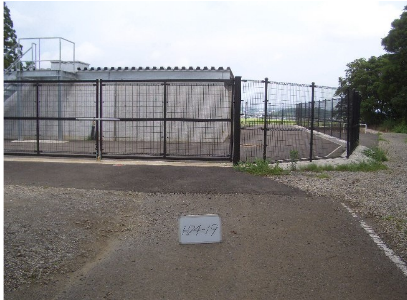
H24-19 栗山川統合機場 吐水槽構内整備工事
