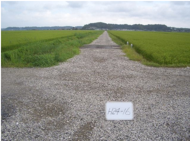
H24-16 南条支線用水路 その1工事
