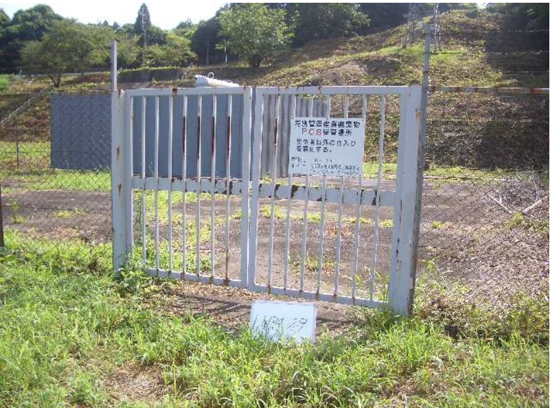
H24-29 微量PCB廃棄物 収集運搬工事
