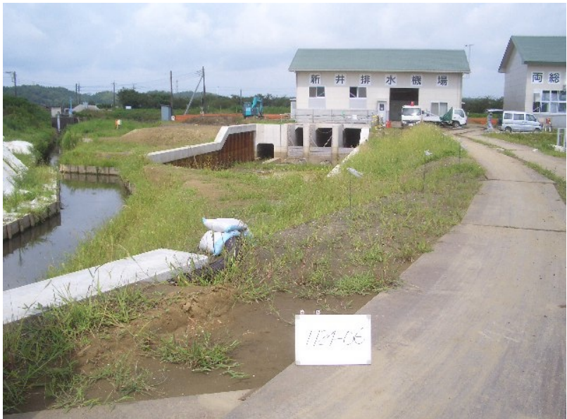
H24-06 栗山川統合機場 排水・注水樋門その他 ゲート製作据付工事
