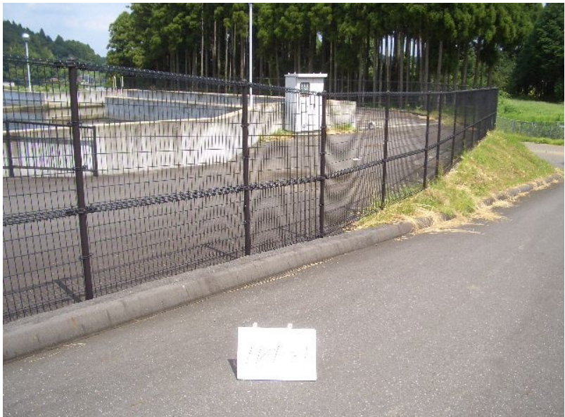
H24-34 第3揚水機場 吐水槽周辺 草刈集草工事
