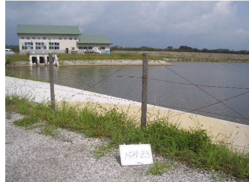
H24-23 栗山川第1調整池 その2工事
