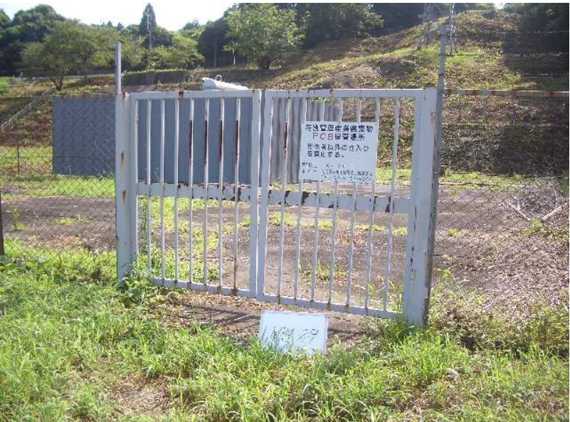
H24-28 微量PCB廃棄物 処理工事
