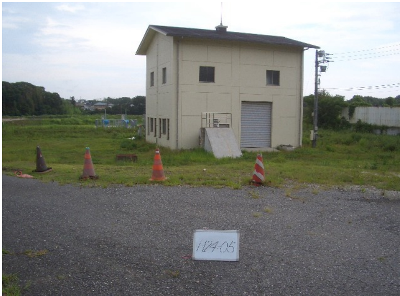
H24-05 山武東部支線機場 場内整備その1工事
