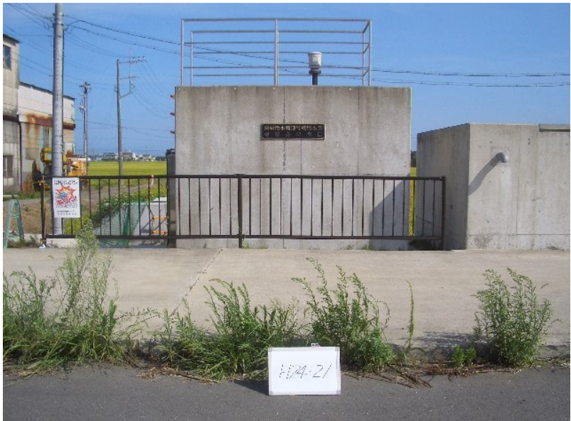
H24-21 南部幹線用水路 他水管理施設製作 据付工事
