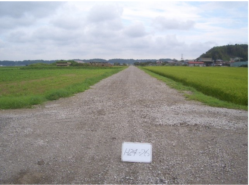
H24-26 南条支線用水路 その3工事
