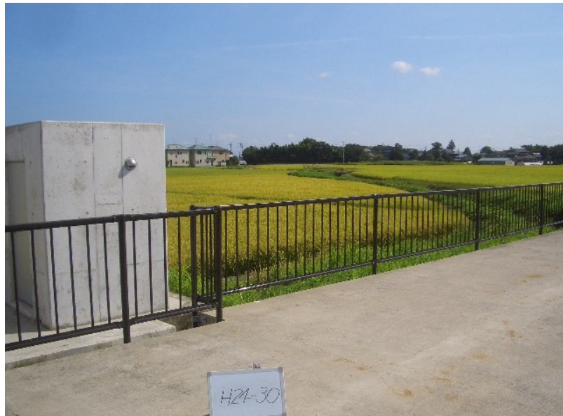
H24-30 福岡南支線用水路 他周辺整備工事
