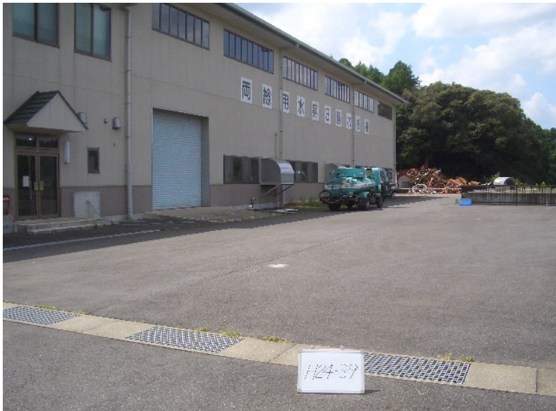
H24-39 第3揚水機場 流入バルブ整備工事
