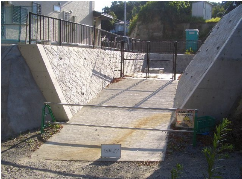
H24-27 南部幹線用水路 周辺整備その2工事
