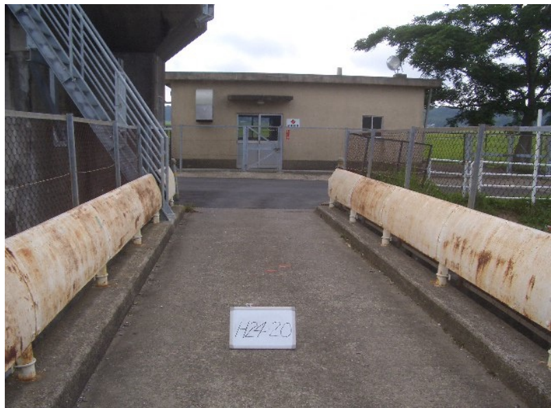
H24-20 篠本堰ゲート 操作卓作成据付工事
