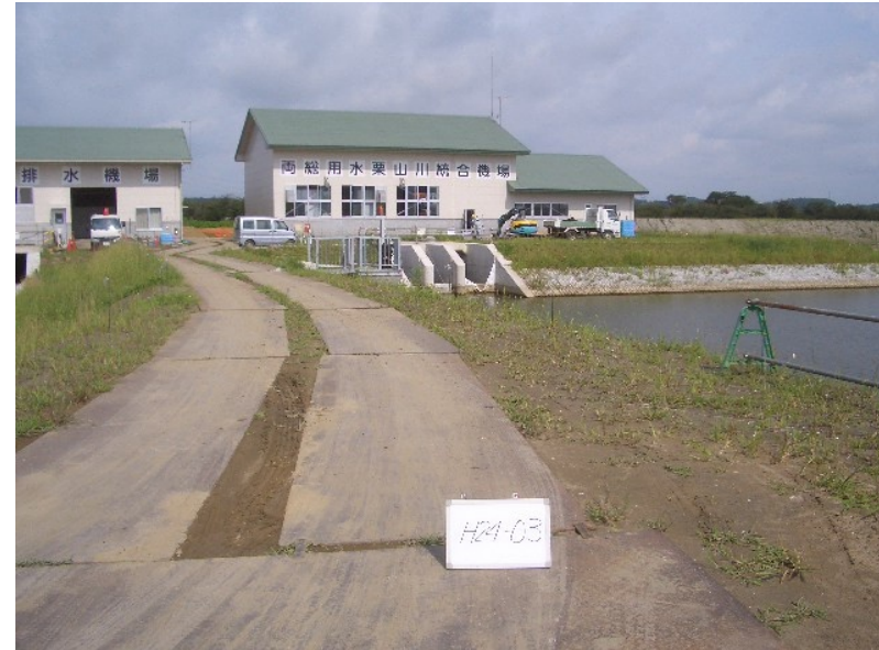
H24-03 栗山川統合機場 下部工その他工事
