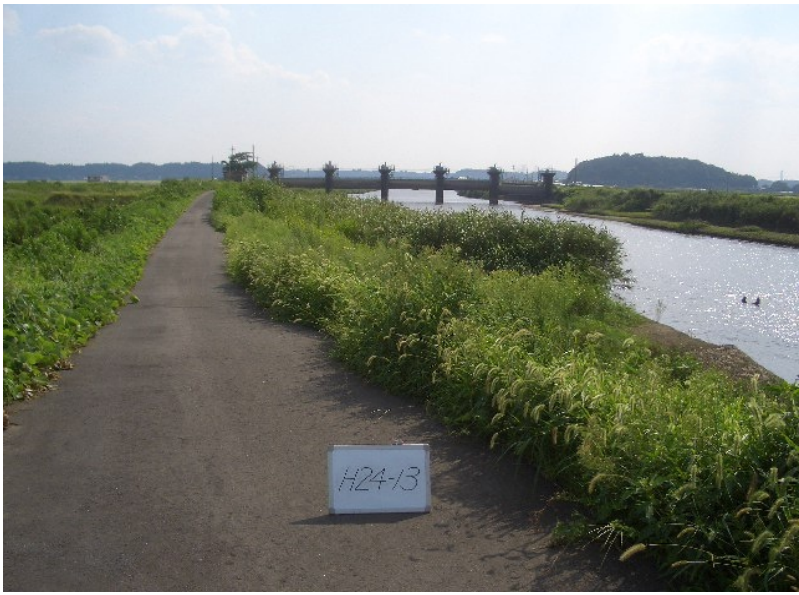
H24-13 篠本堰ゲート 改修その2工事
