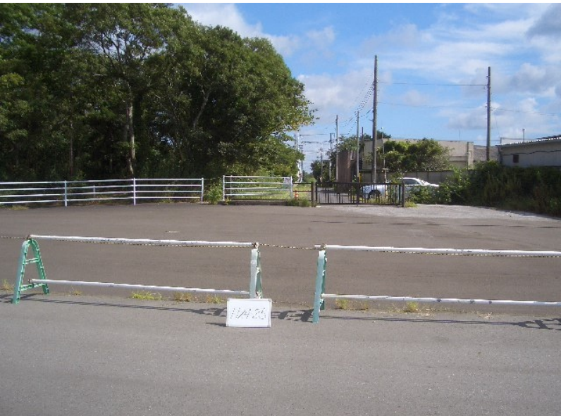
H24-25 松潟支線用水路 撤去工事
