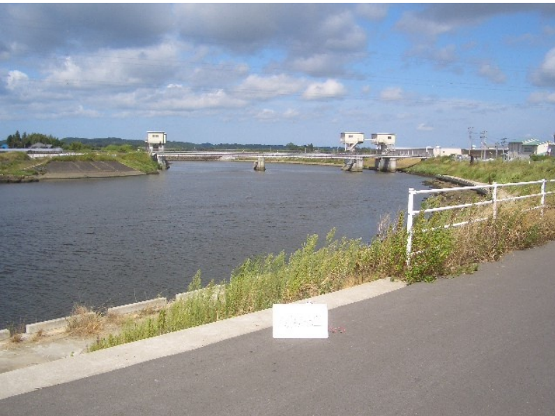
H24-32 松潟堰 付帯設備設置工事
