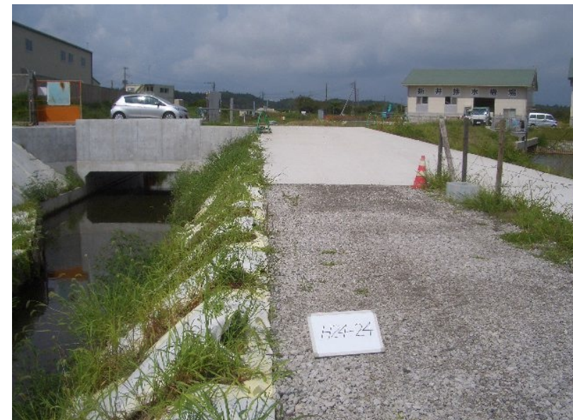
H24-24 栗山川統合機場 送水路その他工事
