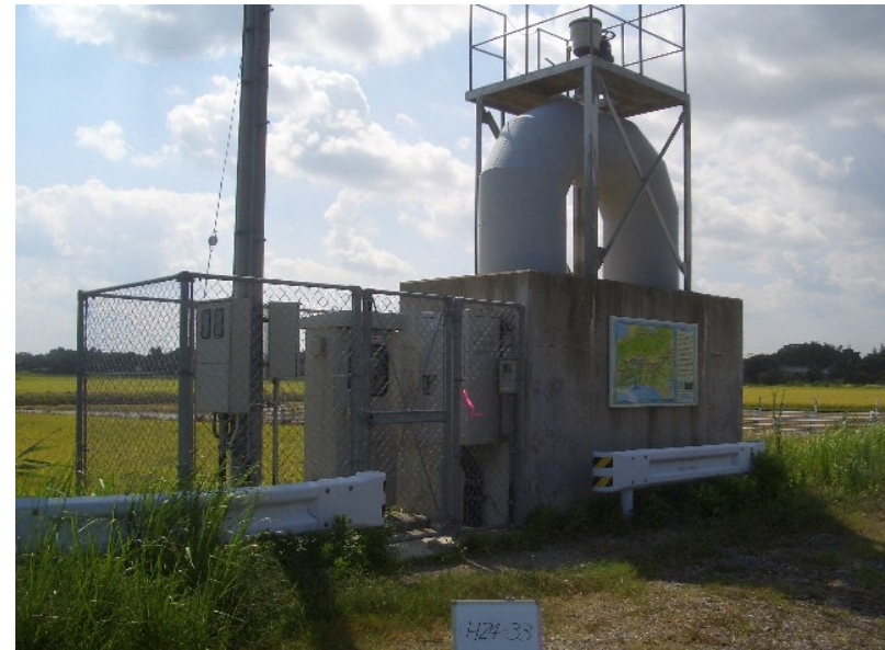
H24-33 福岡東分水工 照明整備改修工事
