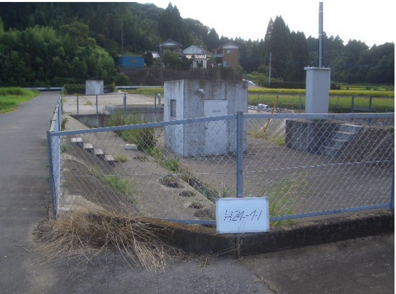
H24-41 松之郷 分水他整備工事
