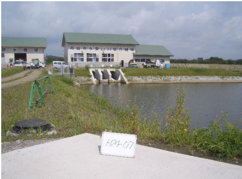
H24-07 栗山川統合機場 ポンプ政策据付 建設工事
