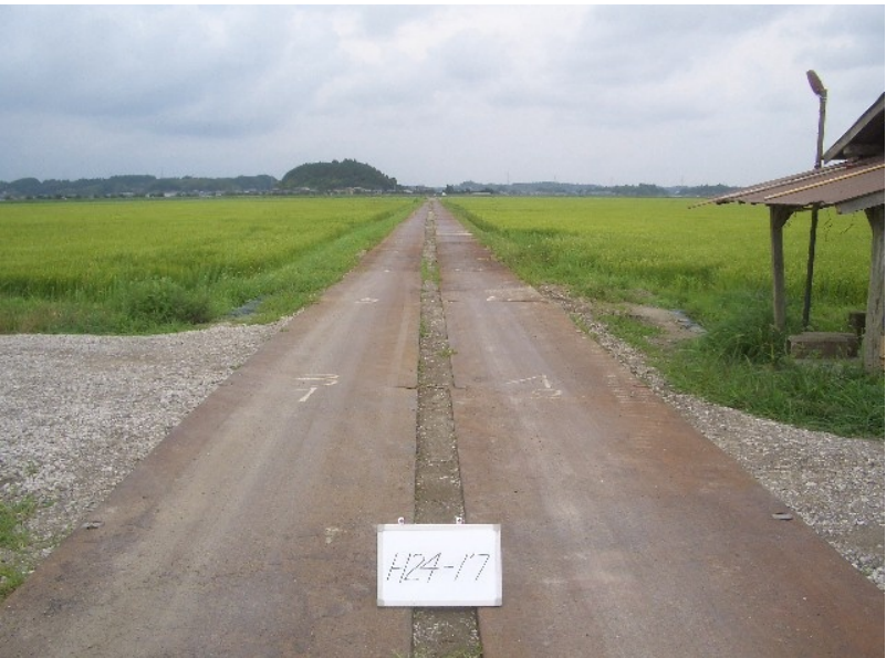
H24-17 南条支線用水路 その2工事
