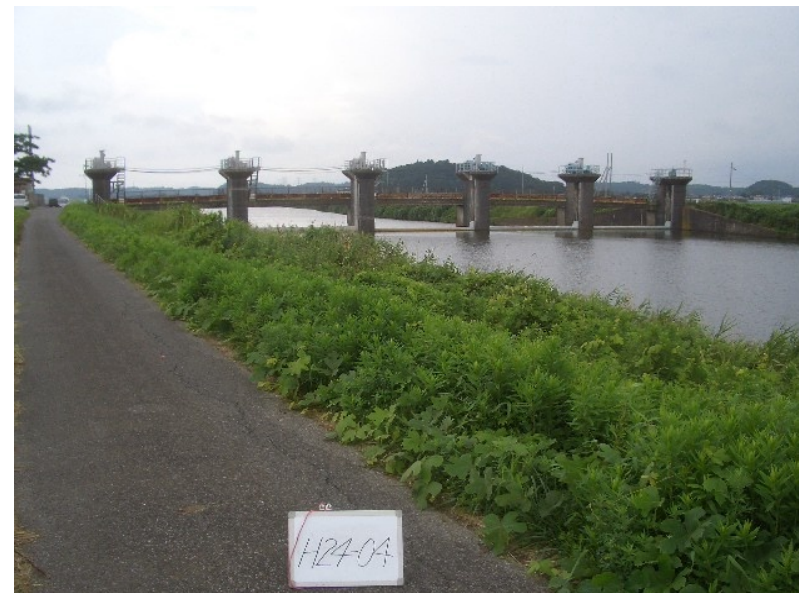
H24-04 篠本堰ゲート 改修その1工事
