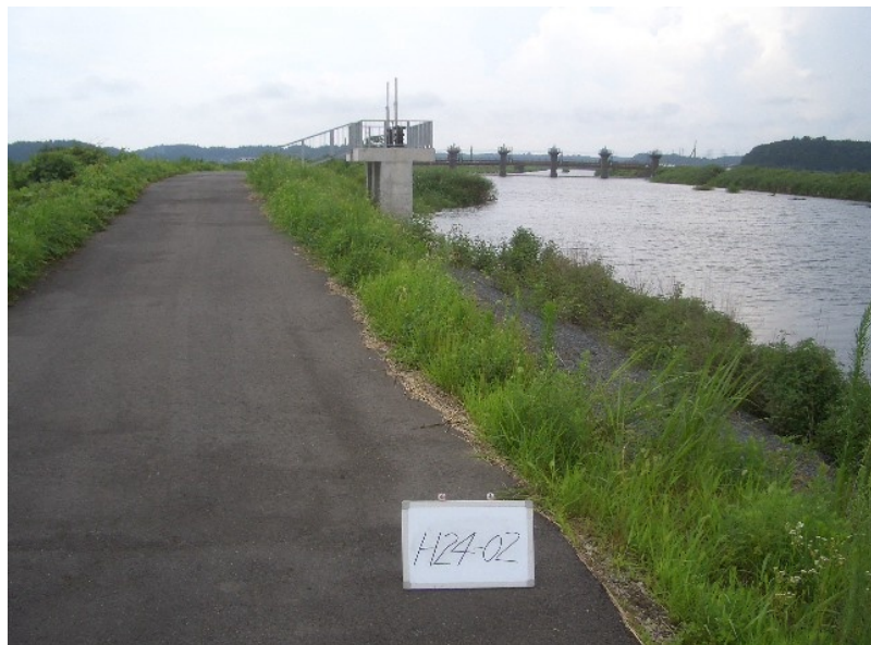
H24-02 栗山川取入樋門 その他工事
