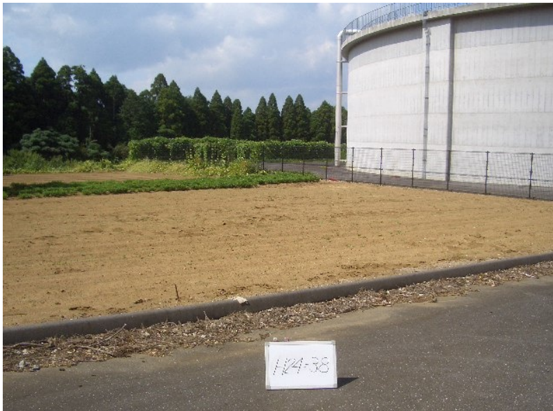
H24-38 第3吐水槽 周辺耕地復旧工事
