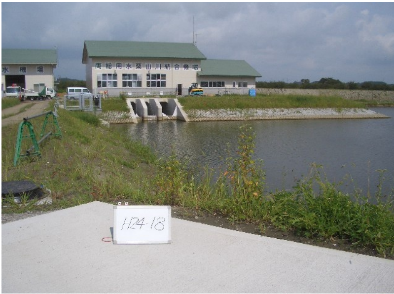
H24-18 栗山川統合機場 上屋建築その他工事
